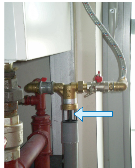
De afvoer van de boiler is duidelijk gescheiden
