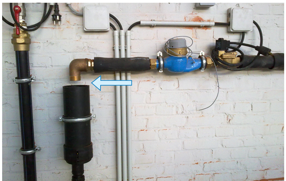
Correct bijvulsysteem voor de regenwaterput
