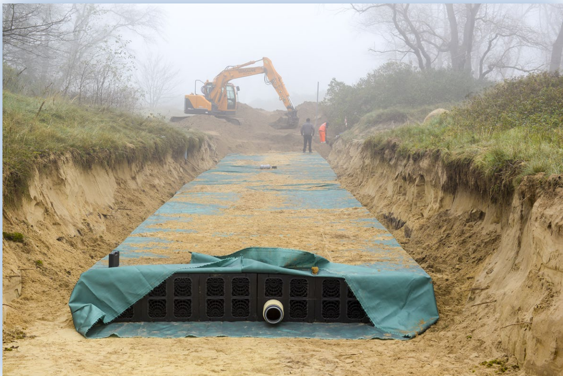
Eind 2014 werd gestart met de aanleg van de ondergrondse infiltratie in het waterwingebied Sint-André. Met de aanleg wil de IWVA de eigen drinkwaterproductie opdrijven. Voorlopig werd gestart met een lengte van 50 meter die bij gunstige resultaten uitgebreid zal worden naar 300 meter.
