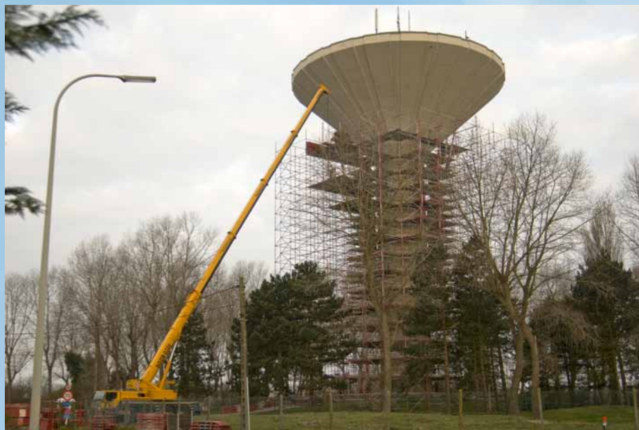
In 2011 kreeg ook de watertoren 'Groenendijk' een grondige opknopbeurt. De firma Kontrimmo had 120 ton stellingen nodig om de watertoren in 20 verdiepingen te kunnen inkleden.
