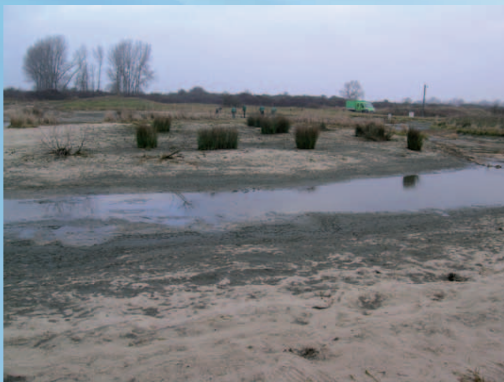
In de maand januari werd het zuidwestelijk deel van het infiltratiepand drooggelegd om de sliblaag die zich gedurende 7 jaar had opgebouwd, te verwijderen. Om de inspanning van het maai-beheer tijdens de laatste jaren niet ongedaan te maken, werd gekozen om het slib af te voeren opdat de grond rondom het infiltratiepand niet verrijkt zou worden.
