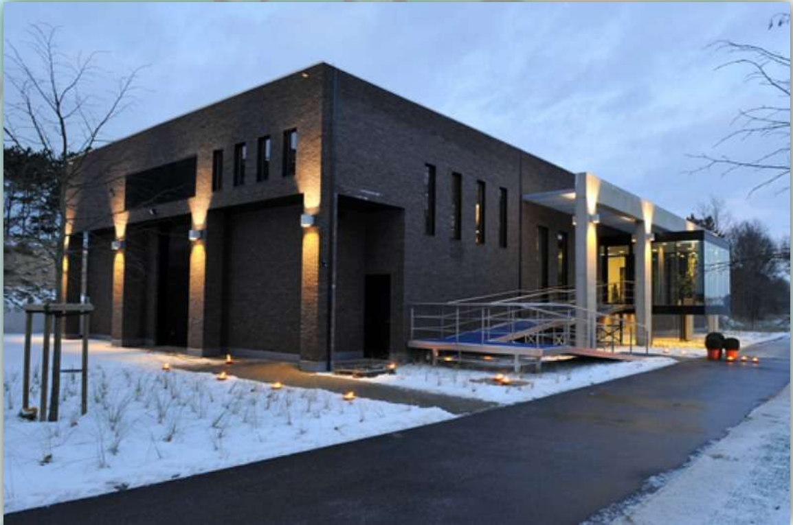
18 december 2009 : Opening van het nieuwe pompstation 'Schipgat' en viering van het 85-jarig bestaan van de I.W.V.A.
