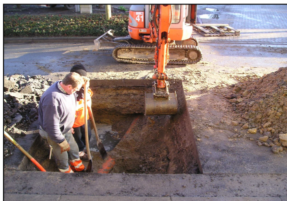
Op zoek naar het precieze tracé van de rioolaansluiting
