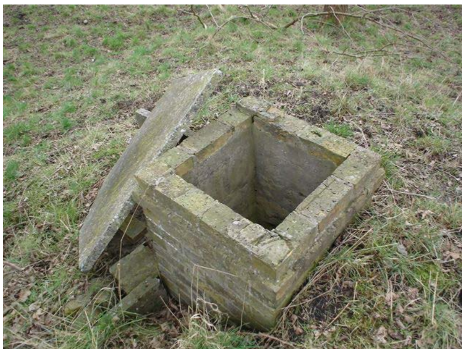
Foto . Het dichtmaken en bedelven van deze schouw is een noodzakelijke ingreep wil men deze bunker geschikt maken voor vleermuizen (foto Bob Vandendriessche).
