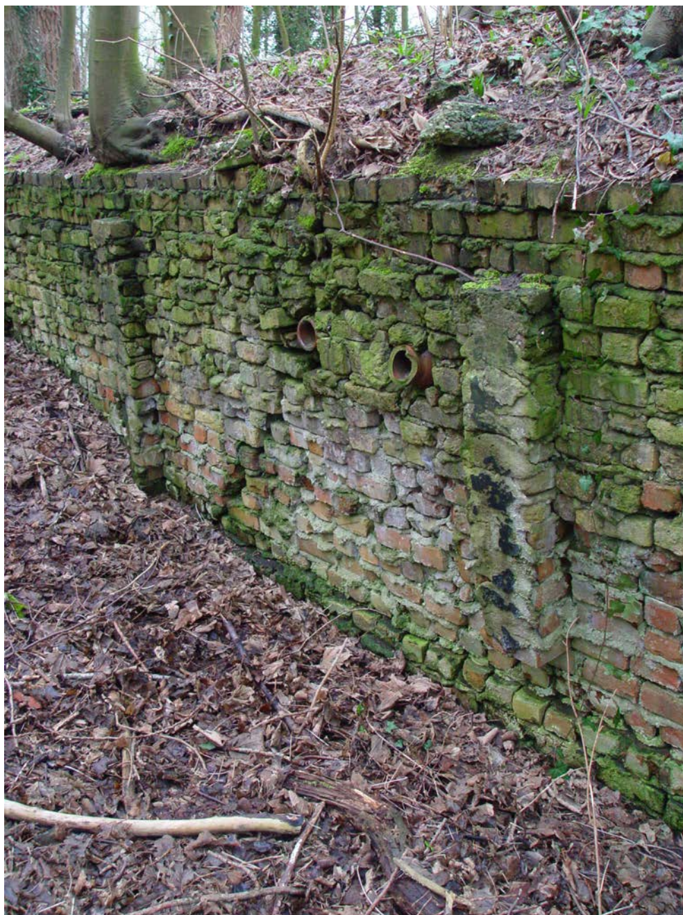
Foto. Cabourduinen. Kelderruimte ten zuiden van het kasteel. Detail muurwerk. foto Johan Termote, 2007
