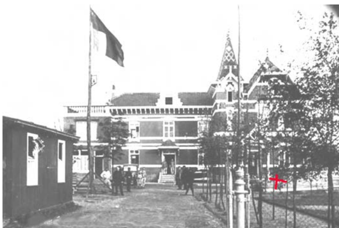
Foto. Het kasteel Cabour vanuit het noorden. Foto verzameling Norbert Desiere.
