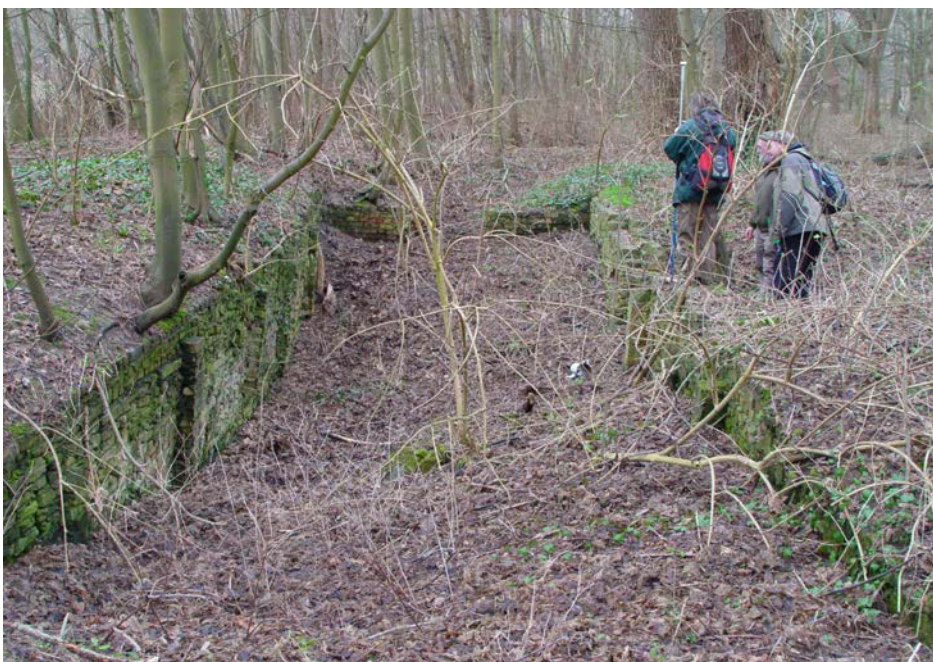
Foto. Cabourduinen. Kelderruimte (functie?) ten zuiden van het kasteel. Algemeen beeld. Foto Johan Termote, 2007.
