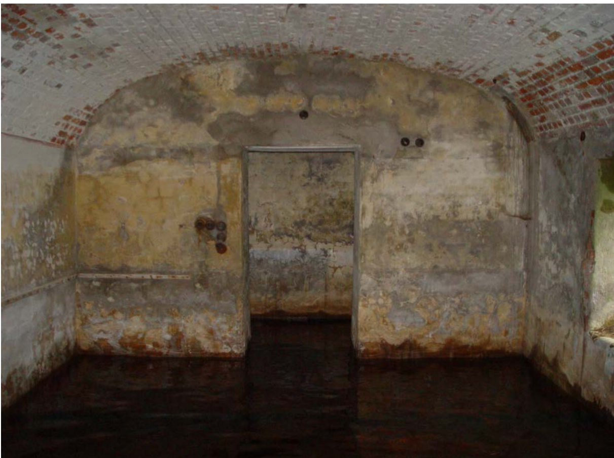
Foto. Militair hospitaal Cabour. Schuilbunker ten zuiden van het kasteel. Interieur. Er staat een halve meter (ingesijpeld regen)water in de bunker. Foto Johan Termote, voorjaar 2007.
