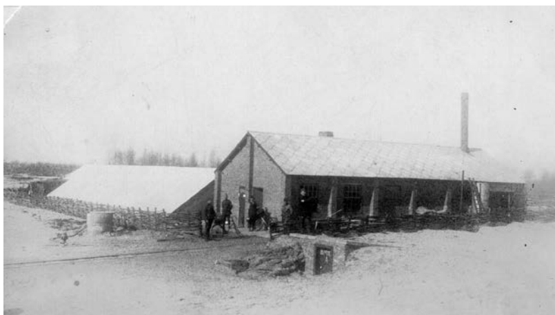
Foto. Pompstation voor waterwinning, vermoedelijk winter 1917-1918. de foto genomen vanuit het zuidoosten.
