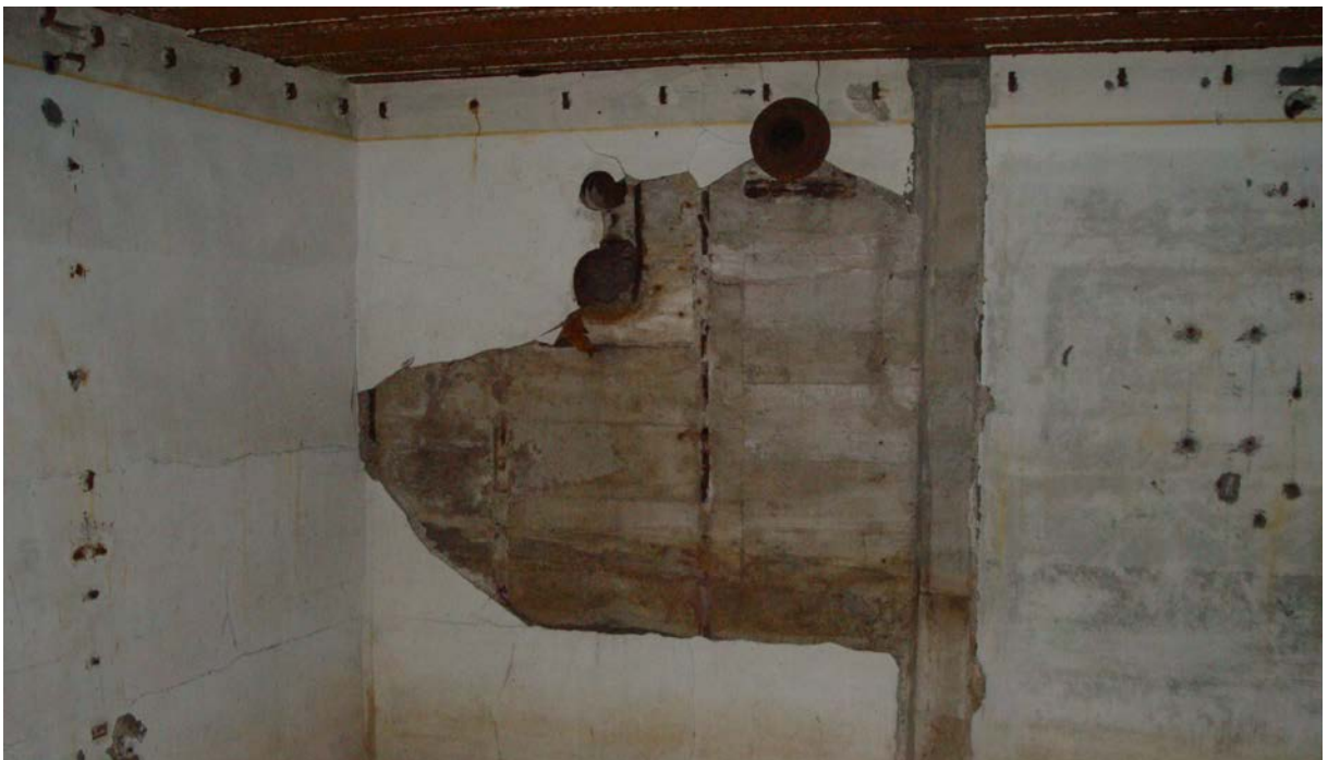
Foto. Cabourduinen. Steunpunt Schlieffen. Commandobunker. Binnenbekleding van herakietplaten. foto Johan Termote, 2007
