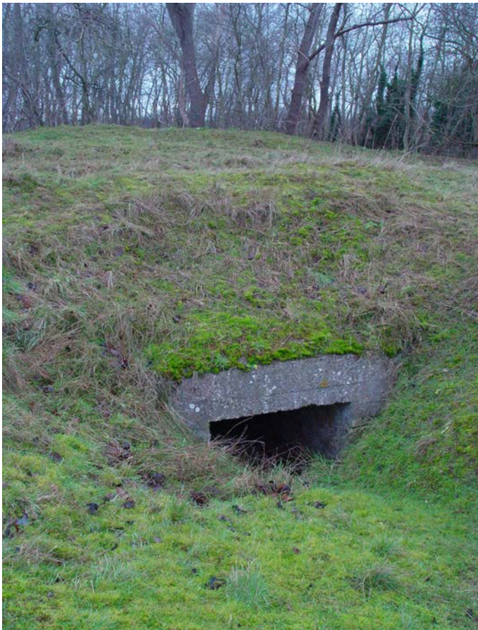
Foto. Cabourduinen. Oostelijke verdedigingslinie WOI. Ingang schuilbunker. foto Johan Termote, 2007
