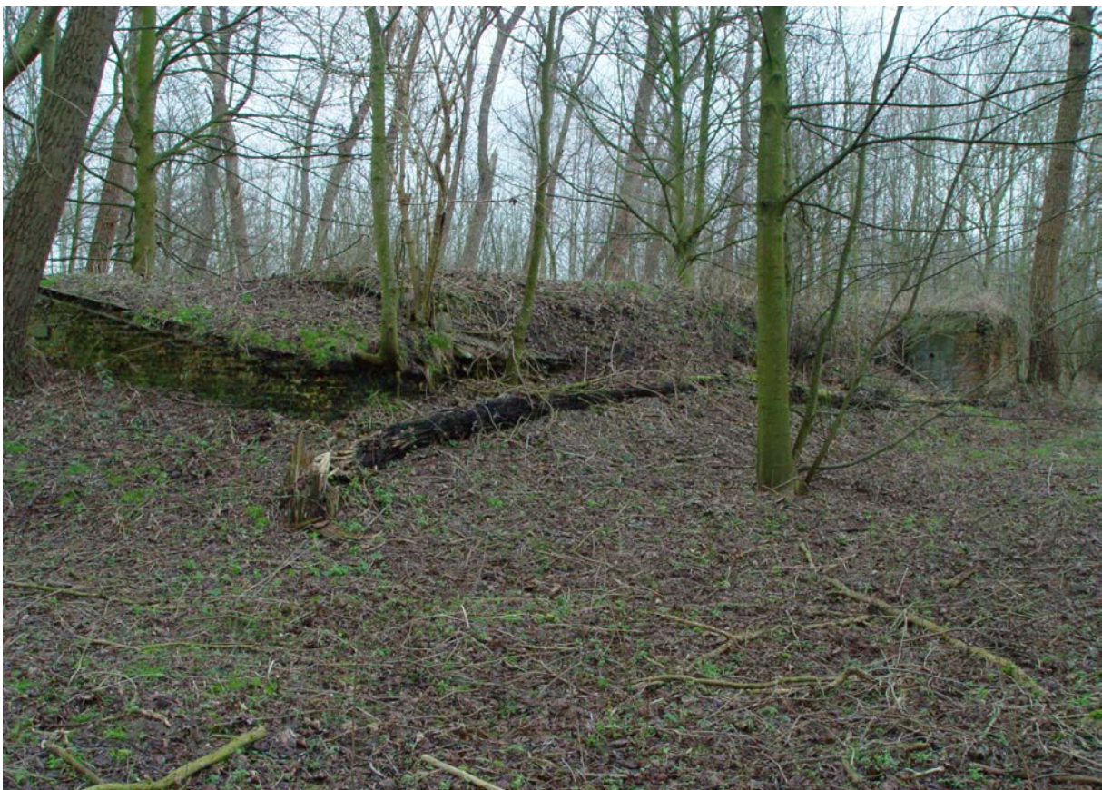
Foto. Militair hospitaal Cabour. Schuilbunker ten oosten van het kasteel. Zicht vanuit het westen. Foto Johan Termote, 2007.
