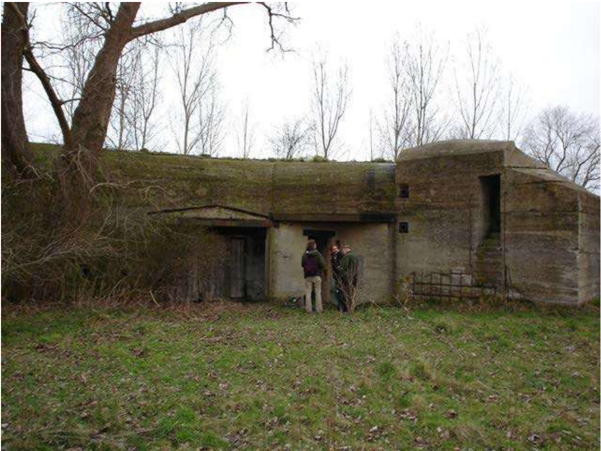
Foto. Eén van de bunkers uit WO II (foto Bob Vandendriessche, 6 februari 2007).
